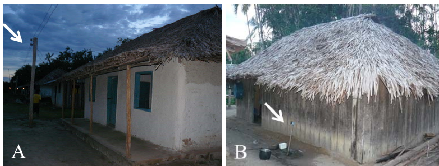
Figura 4. A- Moradias individualizadas construídas em pau a pique e palha e com sistema elétrico. B - Cozinha anexa a unidade doméstica construída de madeira e palha e com o abastecimento de água.
