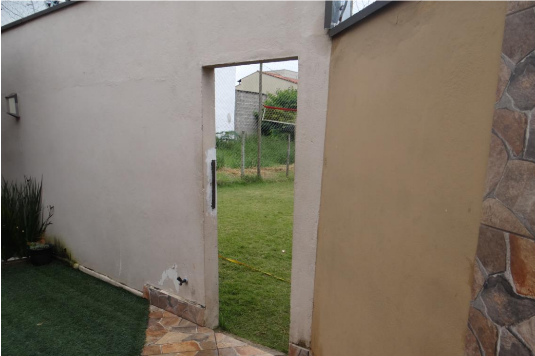
Figura 6 – Portão de acesso do terreno à área invadida de Área Verde
