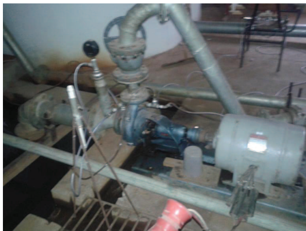
Figura 15 Instalação do conjunto motobomba2
