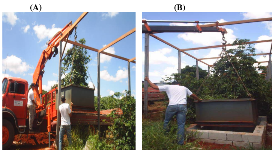
Figura 5 Montagem do lisímetro dentro do ambiente protegido. (A) Detalhe do içamento do conjunto lisimétrico pelo caminhão guincho; (B) colocação do conjunto lisimétrico dentro da estrutura de alvenaria. UFLA, Lavras-MG, 2010
