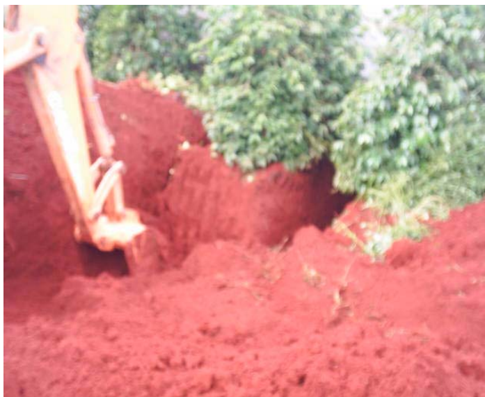
Figura 2 Detalhe da abertura de valetas laterais à planta. UFLA, Lavras-MG, 2010
