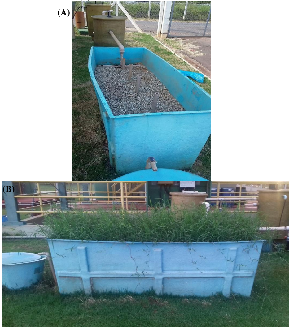
Figura 7 Visualização do processo de montagem do sistema alagado construído utilizado experimentalmente no tratamento do esgoto sanitário da UFLA (A); e vista externa do SAC após o sistema já instalado (B).
