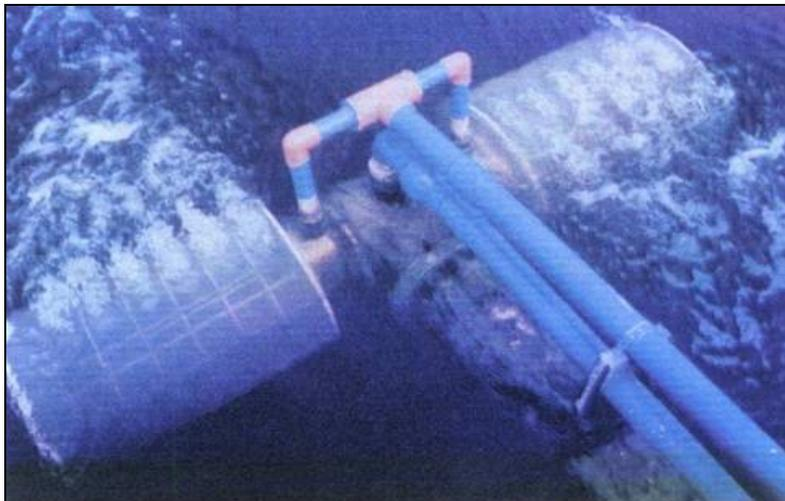
FIGURA 1. Sistema de pré-peneiramento de telas cilíndricas (Fonte: Claude Laval Corporation).
