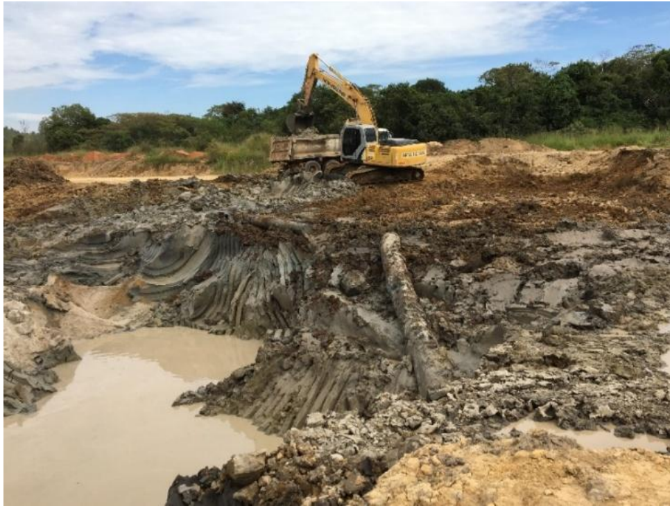
Figura 1 – Escavadeira realizando o processo de extração da matéria-prima.
