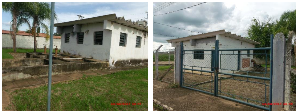
Figura 59 – Imagens do Sistema de Abastecimento Quatis-Formiga.
