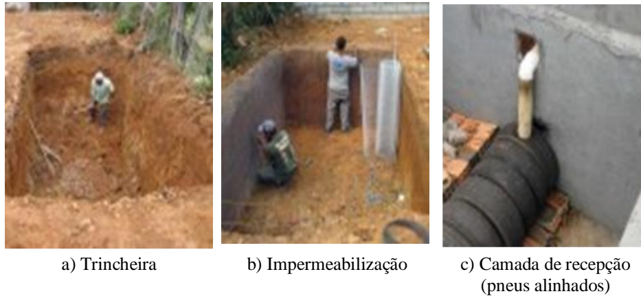
Figura 6 Imagens das etapas de construção da bacia de evapotranspiração Fonte: Vieira (2010)
