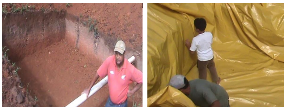
a) Escavação da trincheira
