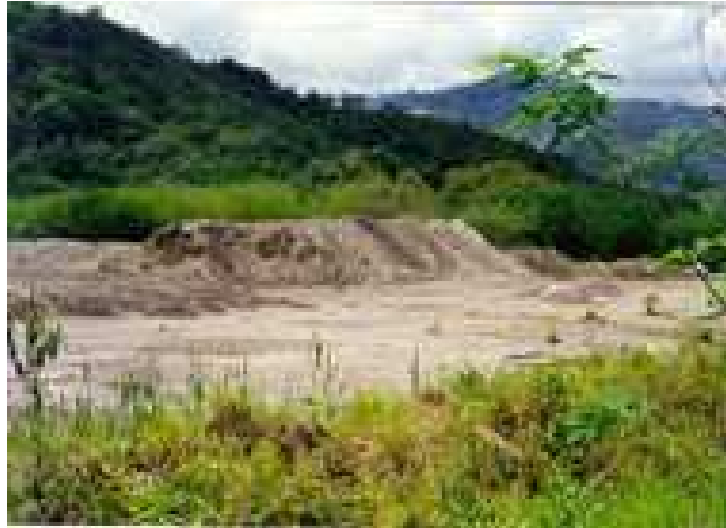
Figura 2.8 – Pilha de Rejeito (UNICAMP, 2008).
