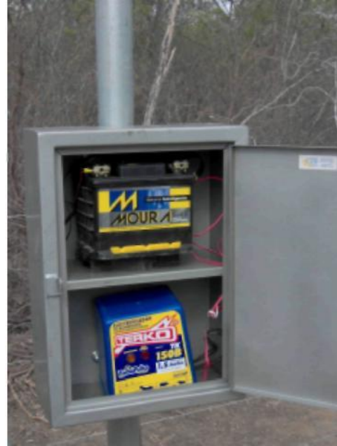
Fig.7 e 8, componentes de um sistema de alimentação fotovoltaico p cerca elétrica
