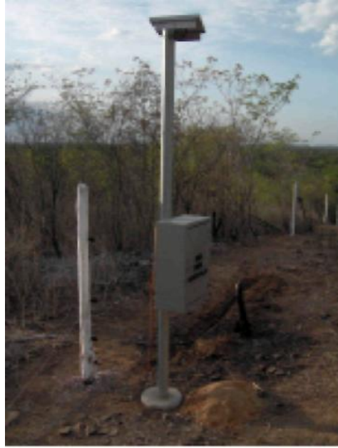
Fig.7 e 8, componentes de um sistema de alimentação fotovoltaico p cerca elétrica
