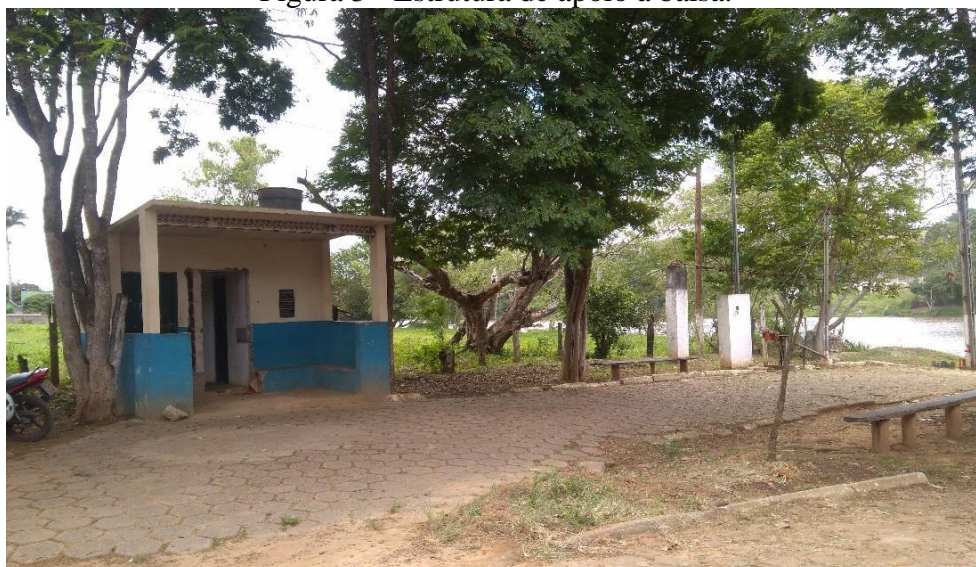
Figura 3 - Estrutura de apoio à balsa.
