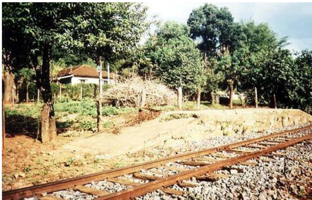
Plataforma de embarque, resquícios da estação de Flora. Fonte: Pereira (2002b).
