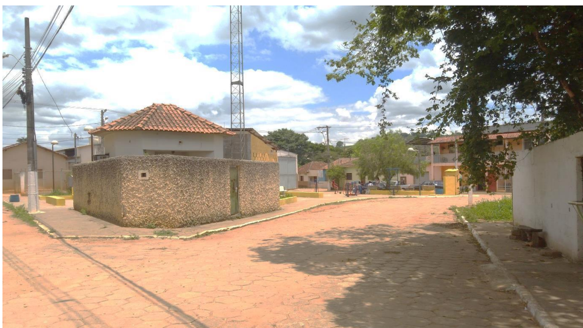
Telefonia no mesmo lote da praça. Fonte: Do autor (2018).
