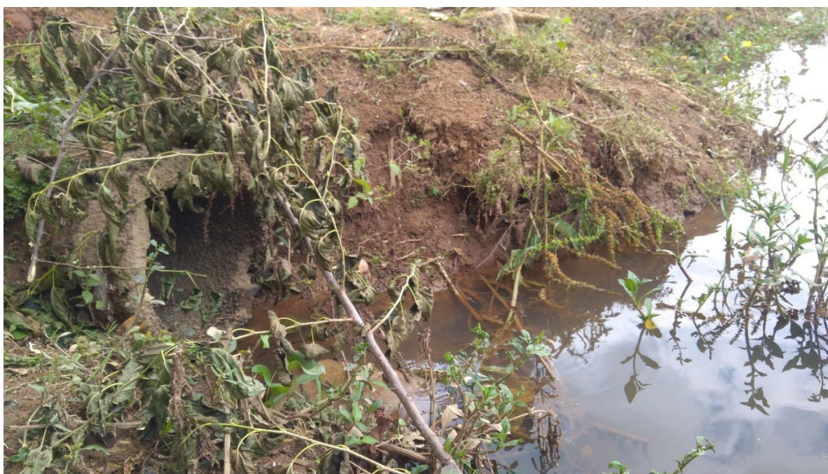
Esgoto sendo lançado ao lado do porto da balsa. Fonte: Do autor (2018).
