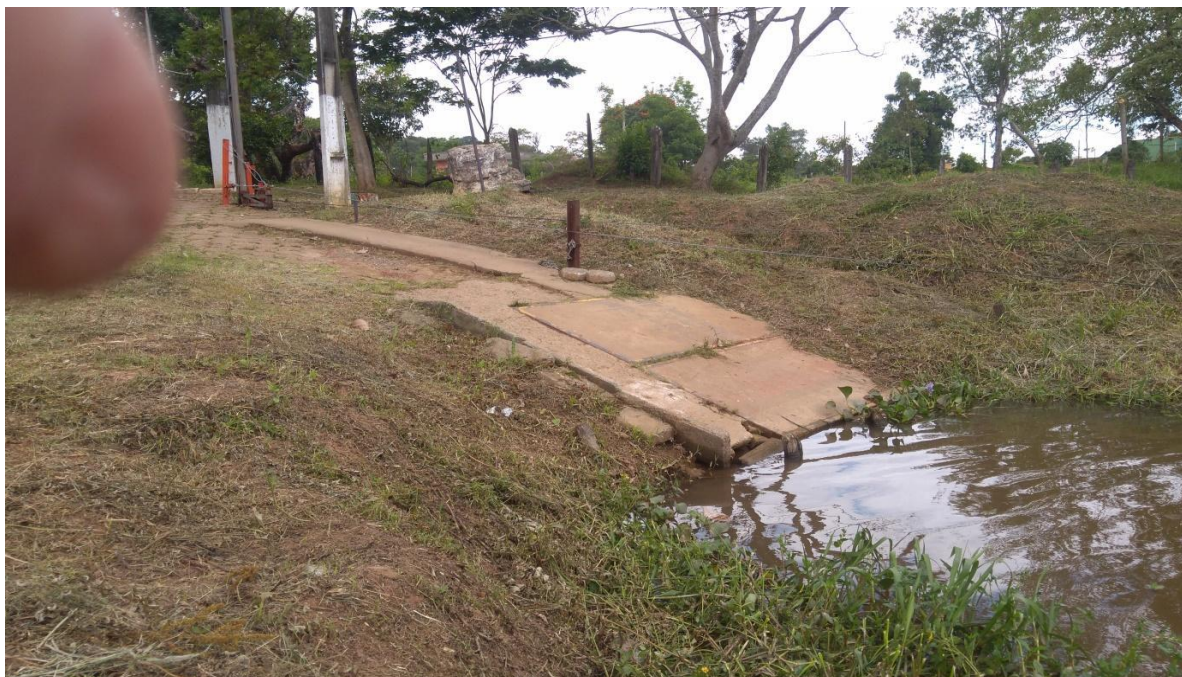
Rampa de acesso à balsa. Fonte: Do autor (2018).
