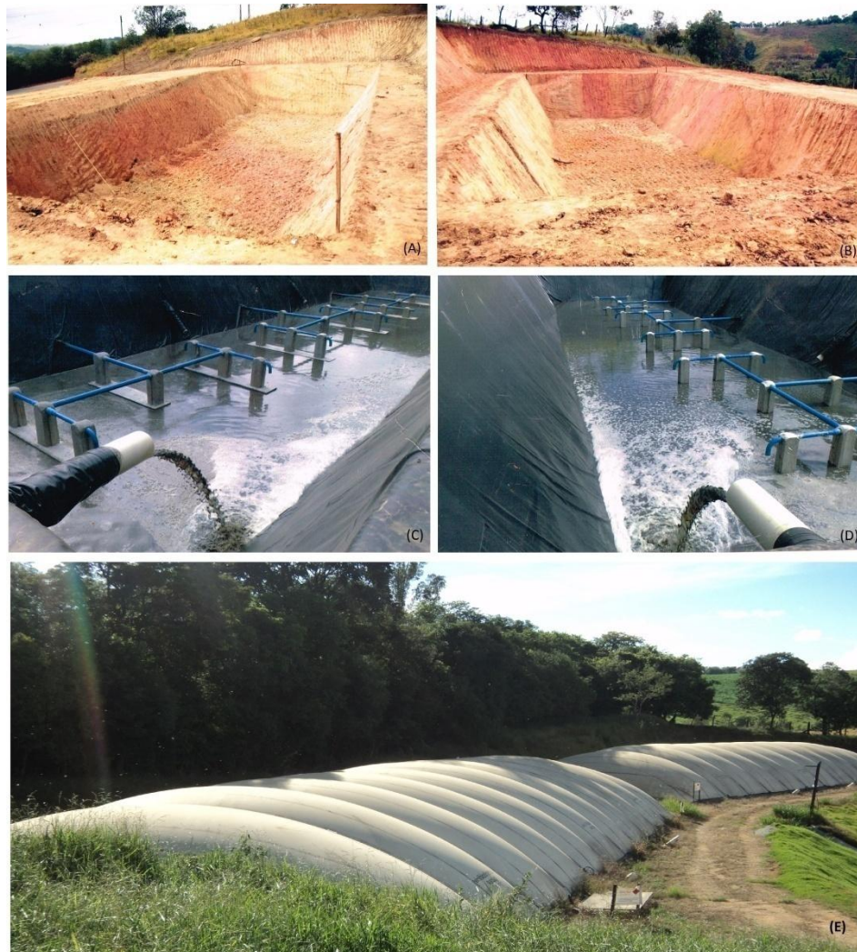
Figura 6. Etapas referentes à construção dos biodigestores: (A e B) escavação dos biodigestores; (C e D) início das operações de enchimento dos biodigestores; (E) biodigestores modelo canadense implantados com destaque para o gasômetro de PVC.
