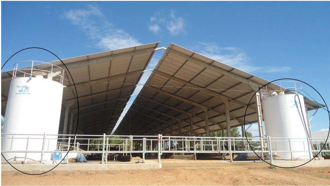
Figura 33 - Reservatório de biofertilizante para realizar o flushing , galpão 1.
