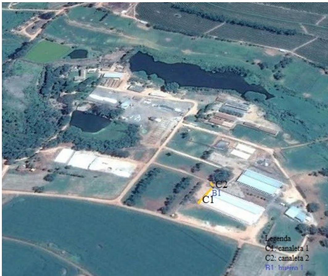
Figura 15 - Identificação das canaletas do galpão de free stall 1 .
