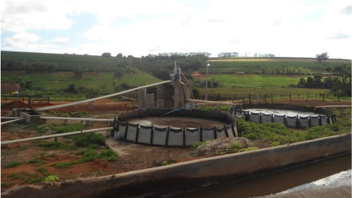
Figura 4 - Tanques de decantação localizados antes do biodigestor.
