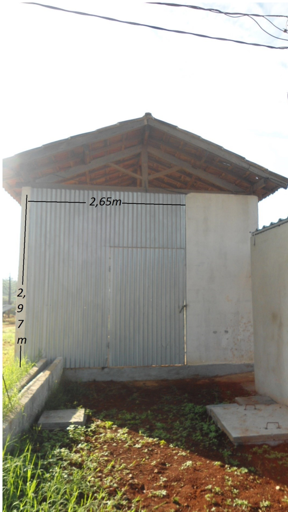
Figura 10 - Entrada do abrigo do grupo gerador.
