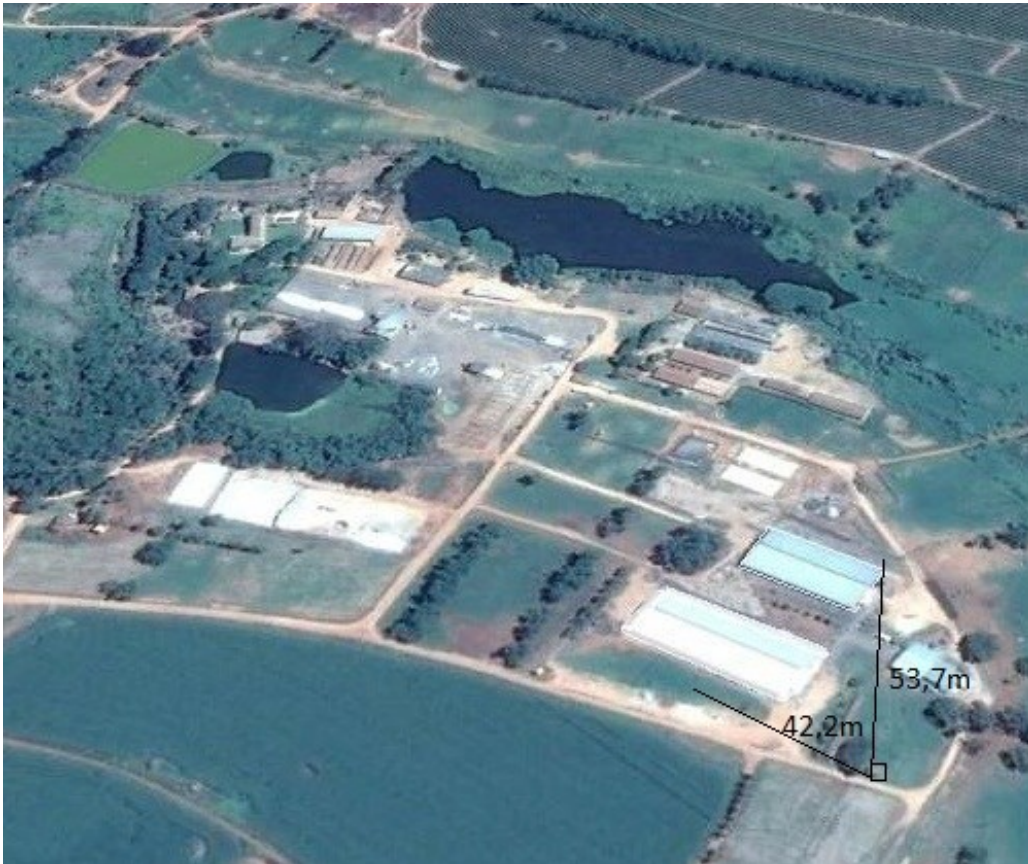
Figura 12 - Rede de distribuição de energia elétrica do grupo gerador para os galpões de free stall .
