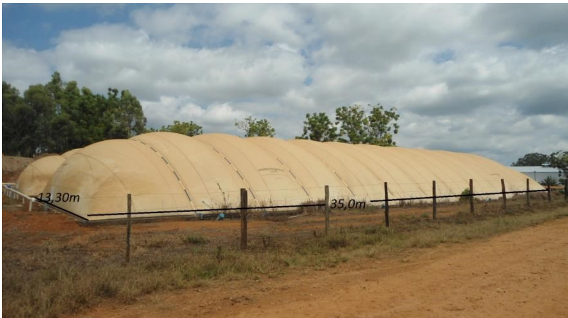
Figura 5 - Cúpulas do biodigestor.
