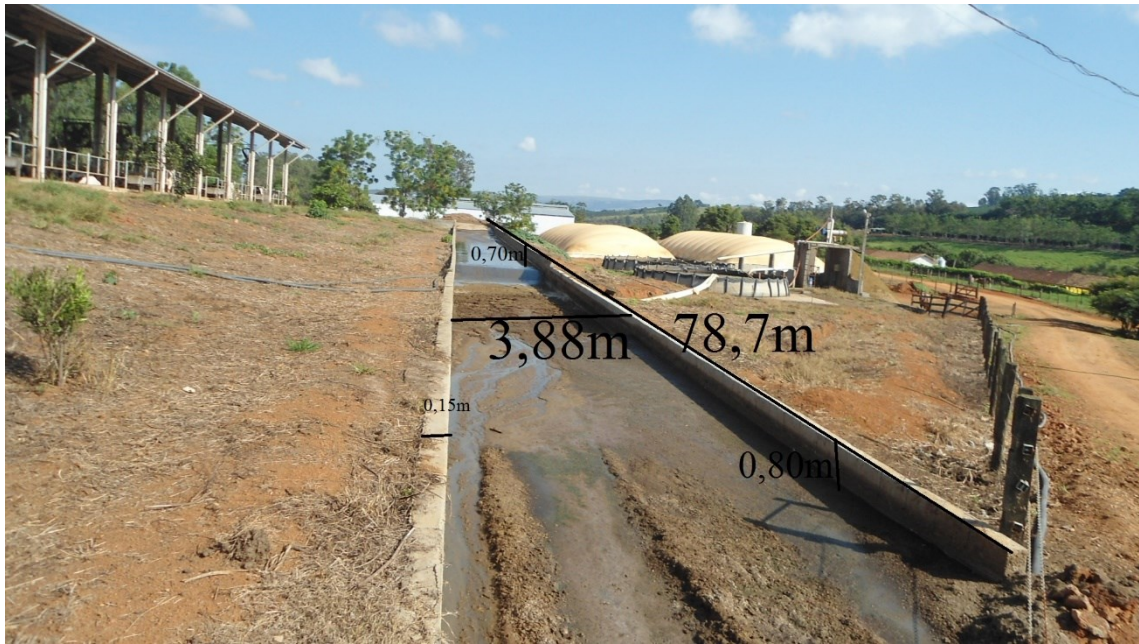
Figura 27 - Dimensões da pista de decantação 2.
