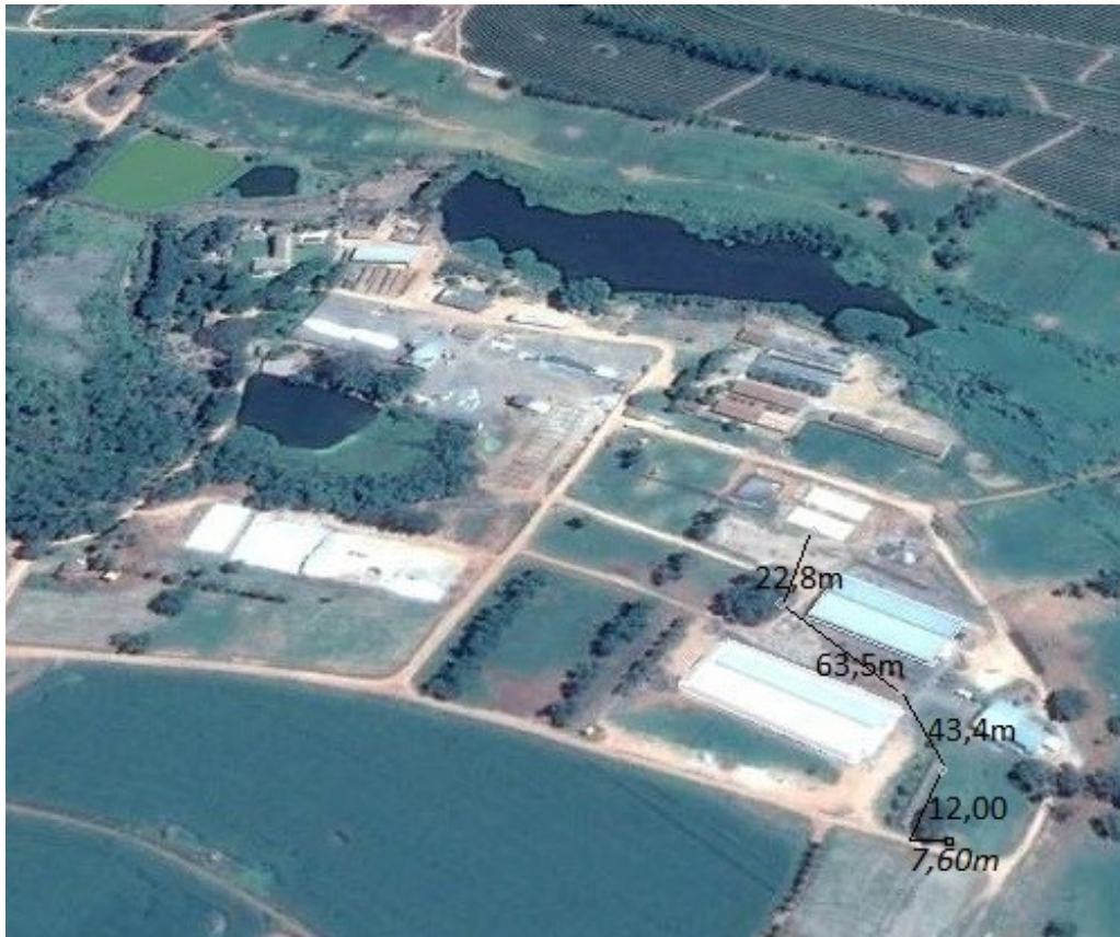
Figura 11 - Canalização do gás das cúpulas para o grupo gerador.
