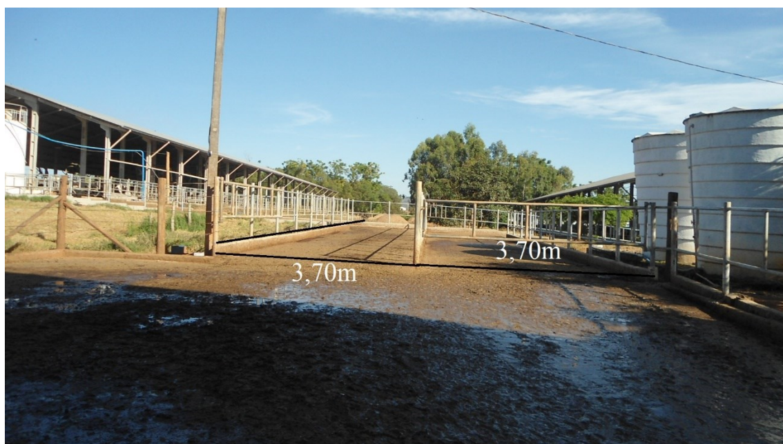
Figura 49 - Corredor de acesso a ordenha.
