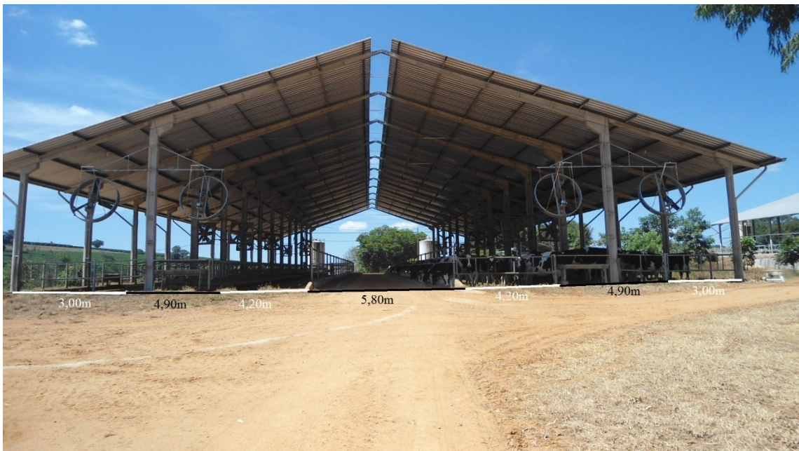
Figura 41 - Largura do galpão 2.
