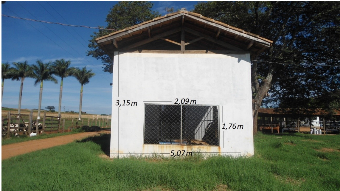
Figura 8 - Fundos do abrigo do grupo gerador.
