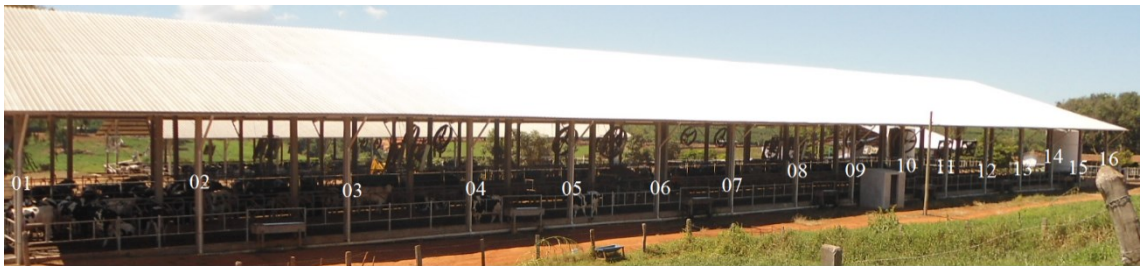
Figura 29 - Encanamento da captação de água de telhado do galpão 1.
