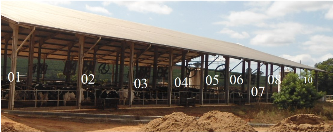
Figura 31 - Encanamento da captação de água de telhado do galpão 2.
