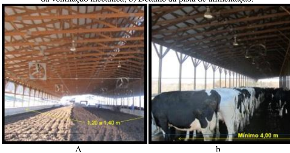
Figura 4 - Ilustração de um galpão para rebanho leiteiro em sistema Compost Barn . a) Detalhe da mureta e da ventilação mecânica; b) Detalhe da pista de alimentação.
