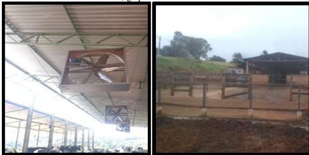
Figura 10- Imagens do galpão em sistema Compost Barn . (a) detalhe dos ventiladores; (b) galpão de ordenha.
